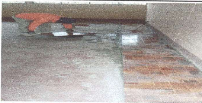
Foto 5: Sustitucion piso de torta de cemento por piso ceramico
