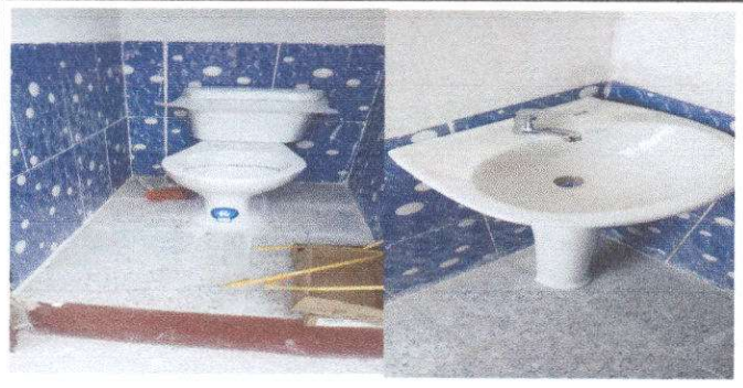
Foto 4: Sustitución inodoro, sustitución lavamanos
