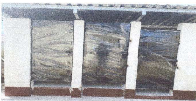
Foto 5: Sustitución puertas en servicio sanitario
